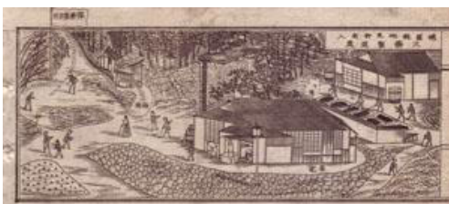
↓弾薬製造所 火薬製造処
