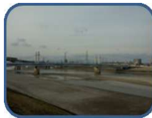
【現在の大和橋】
