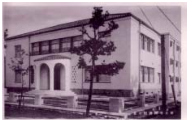
昭和11年に新築された市立堺図書館
